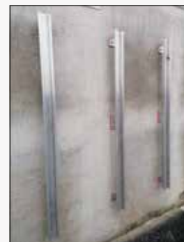
Fissaggio dei pannelli ai profili
