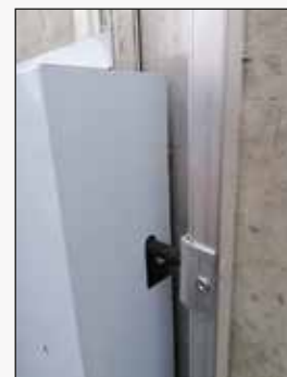
Fissaggio dei pannelli ai profili
